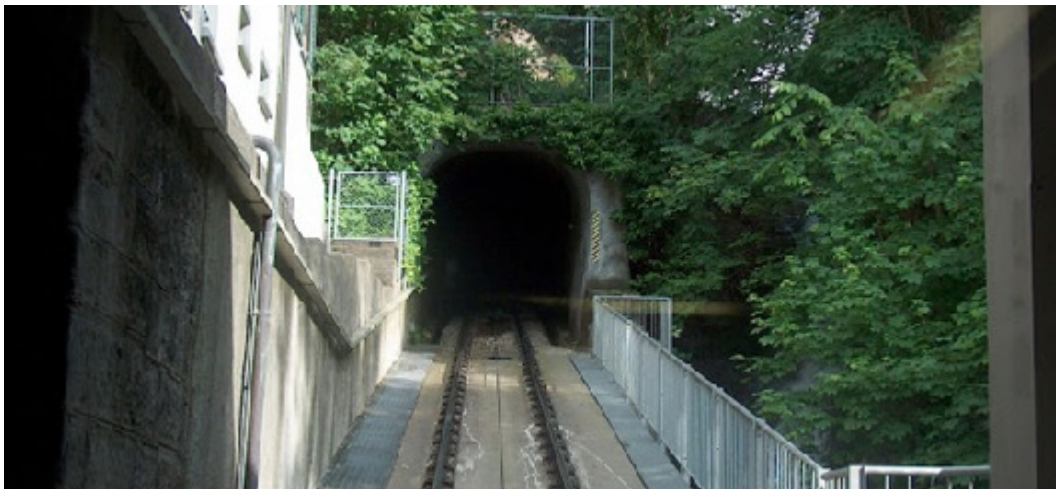
Mühlegg-Tunnel, 9000 St. Gallen
